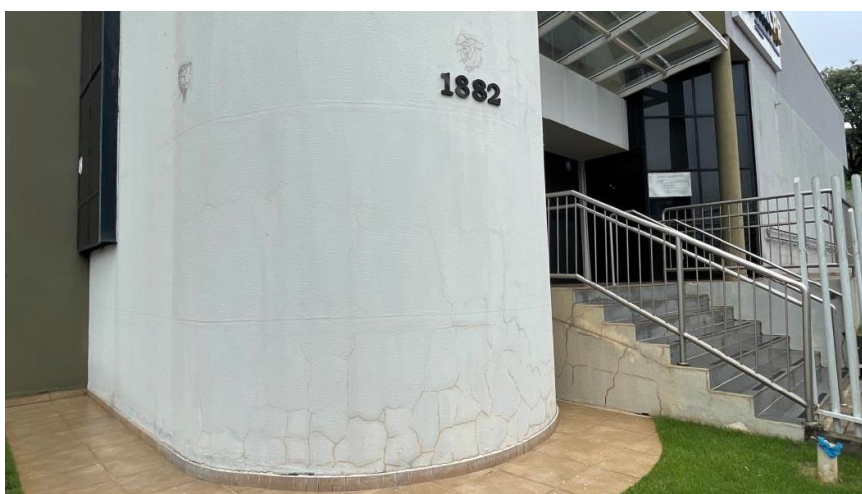
Imagem 2 – Fissuras higroscópicas na fachada
