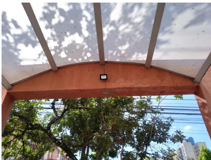
Imagem 7 – Vista inferior da marquise de entrada
