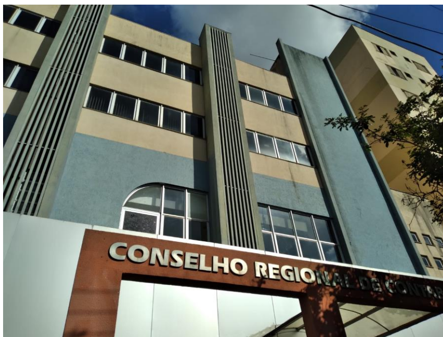
Imagem 6 – Facha do edifício
